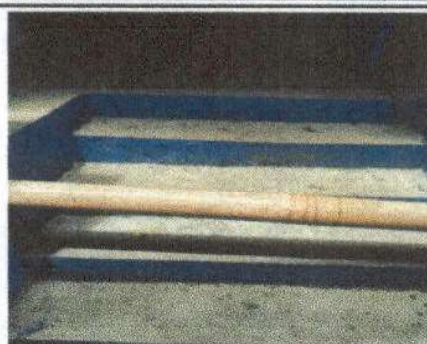
Foto 14: Elaboracion de gradas
