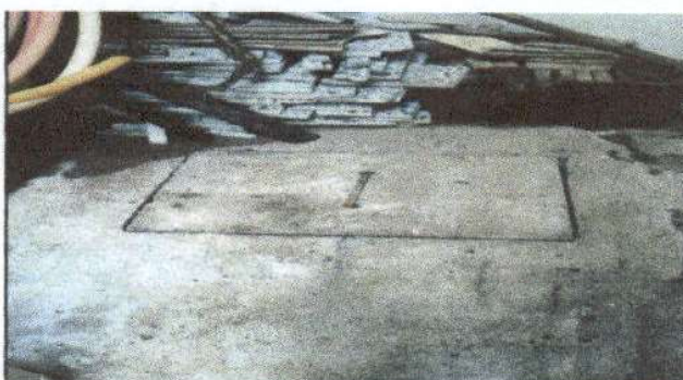
Foto 10: Sustitucion de caja de registro
