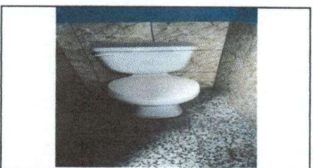
Foto 6: Sustrucion de inodoros
