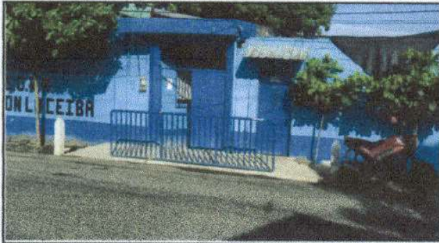
Foto 1: Sustrucion de baranda de metal de seguridad y plancha de concreto en el ingreso del establecimiento
