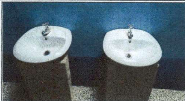
Foto 7: Sustitucion de lavamanos
