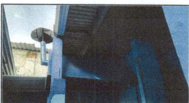
Foto 12: Sustitucion de Chimenea
