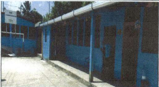
Foto 2: Sustrucion de canal de metal
