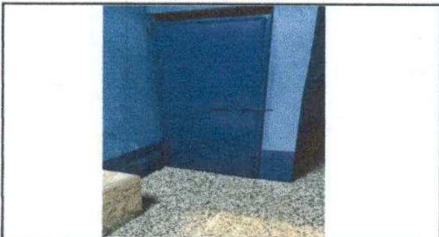
Foto 3: Sustrucion de puertas de metal de sanitarios
