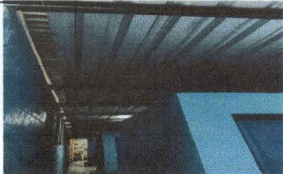
Foto 13: Sustitucion de techo de baños
