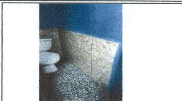
Foto 8: Sustitucion de azulejo
