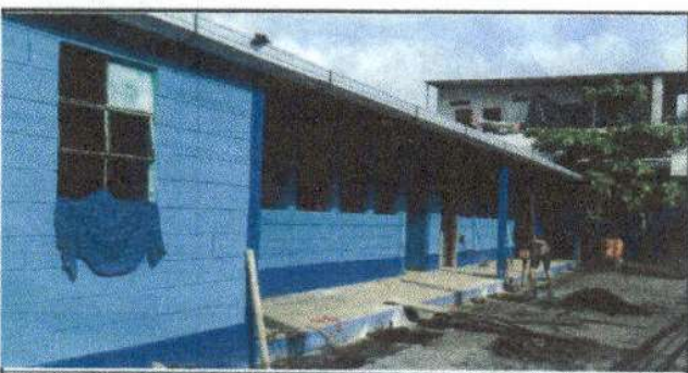
Foto 5: Pintura de muros exteriores e interiores
