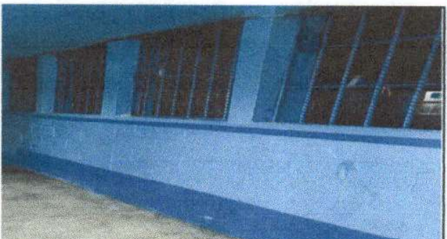
Foto 4: Sustrucion de Balcones de Metal
