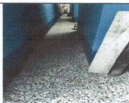
Foto 16: Sustitucion de piso de torta de cemento por piso de granito
