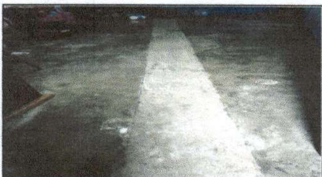
Foto 9: Sustitucion de tubería de aguas negras
